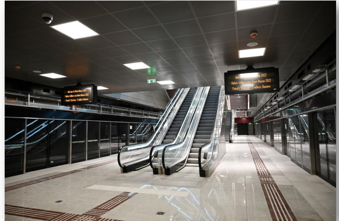
Σταθμός Παπάφη Επίπεδο αποβάθρας
